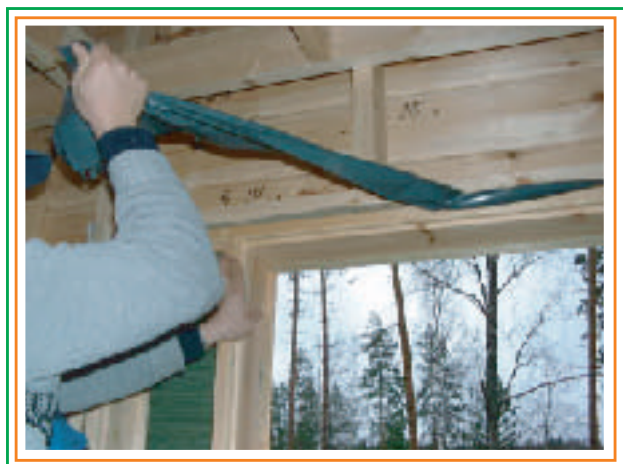
6. Poistetaan muovi.
