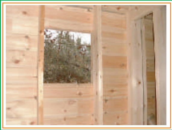
1. Tehdään ikkuna-aukko runkoon.
